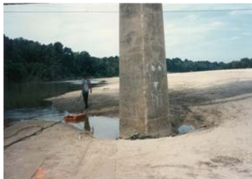
(a) Kolk an einem Brückenpfeiler nach einem Hochwasser (Homochitto River, Bude, MS, USA)
