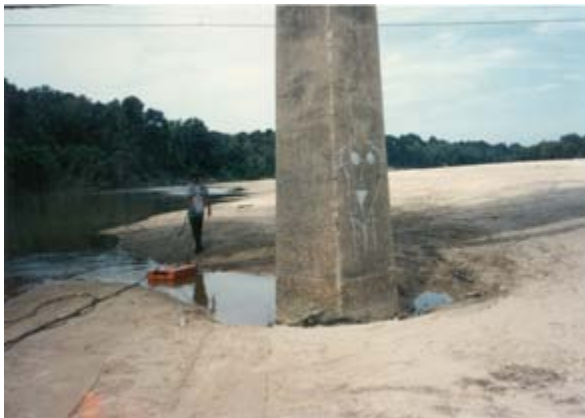
(c) Kolk an Brückenpfeiler
